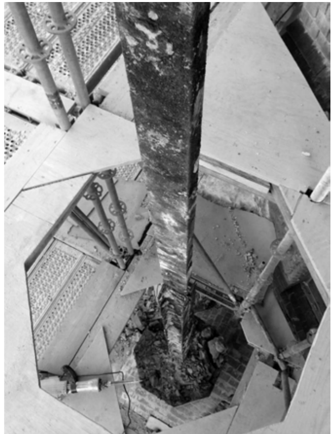
Verrosteter Stahlkern eines Filialturms, der die Backsteine auseinandersprengt und Risse verursacht.
