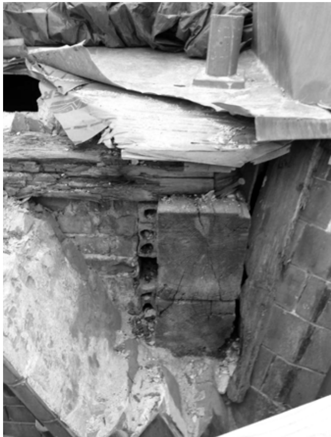
Verrottete und defekte Holzbalken in der Decke der Kirchturmspitze.
